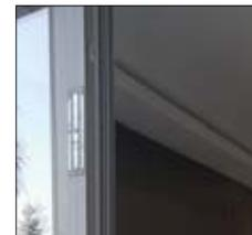
**Ventouse électromagnétique** facilitant le contrôle des accès à la porte
